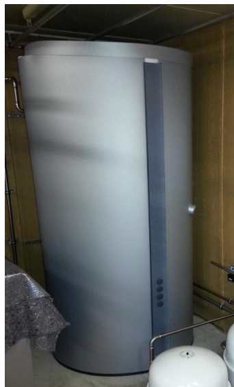
Abbildung 94: Im Projekt LEXU II eingesetzter Pufferspeicher Vitocell 140-E, Firma Viessmann GmbH & Co. KG
