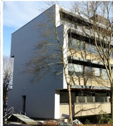
Abbildung 2: Foto der Fassade des Demonstrator-Gebäudes, nach der Sanierung
