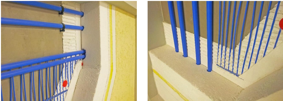
Abbildung 53: Detailaufnahme der Musterwand mit der Ausklink-Lösung
