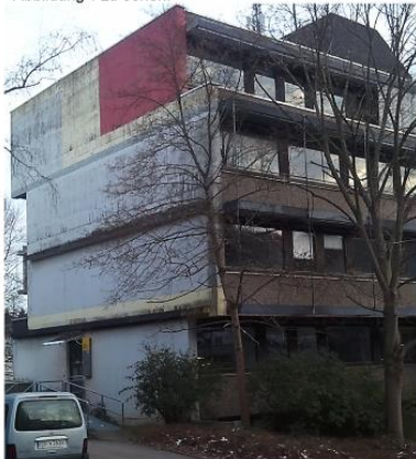
Abbildung 1: Foto der Fassade des Demonstrator-Gebäudes, vor der Sanierung
