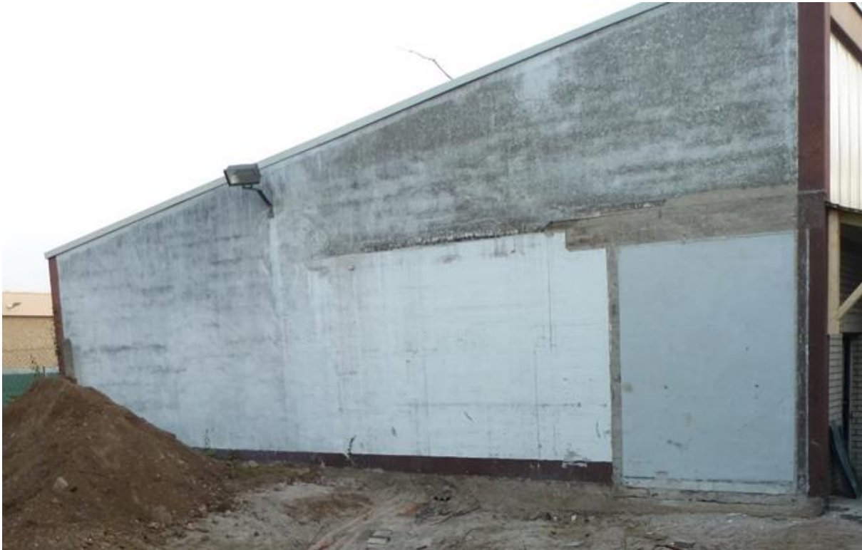
Abbildung 2 Arbeiten zur Vorbereitung der Demonstrationsfassade [Bildquelle: KOMZET BAU BÜHL]
