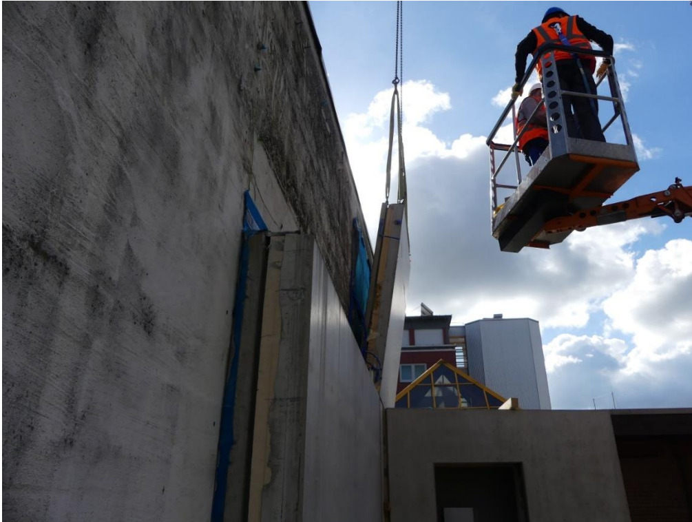
Abbildung 7: Lösen des Elements 1
