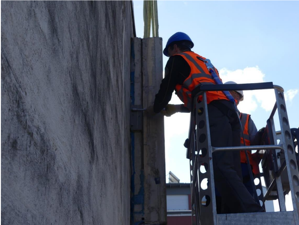
Abbildung 4: Lösen der Muttern der Stahlschienen an eingeklebten Gewindestangen
