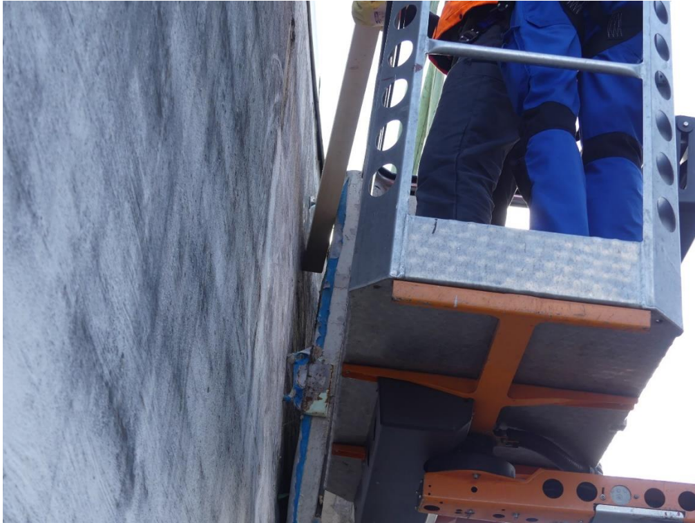
Abbildung 6: Lösearbeiten mittels Kantholz
