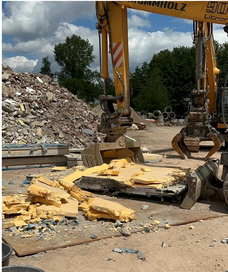
Abbildung 20: Ablösen der Dämmebene
