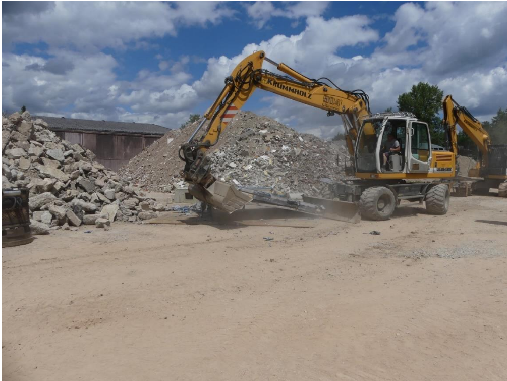
Abbildung 18: Trennen der Sandwich-Schalen
