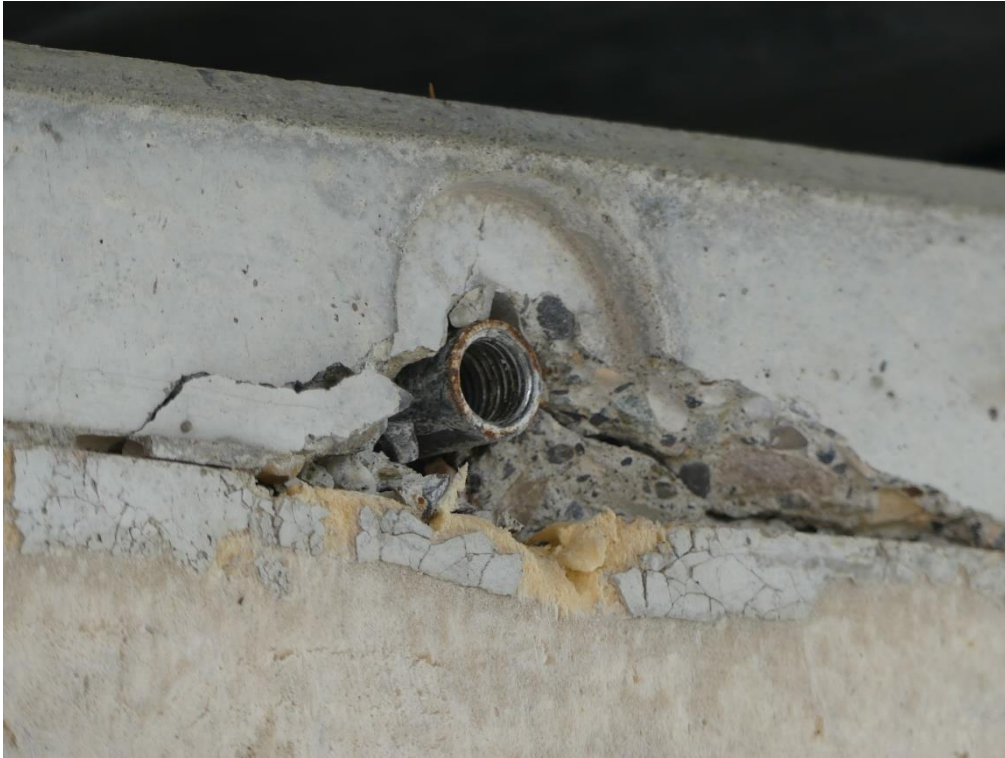
Abbildung 15: Ausbruch Traganker
