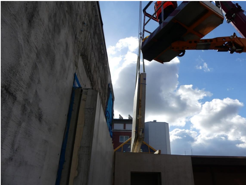
Abbildung 8: Lösen des Elements 2
