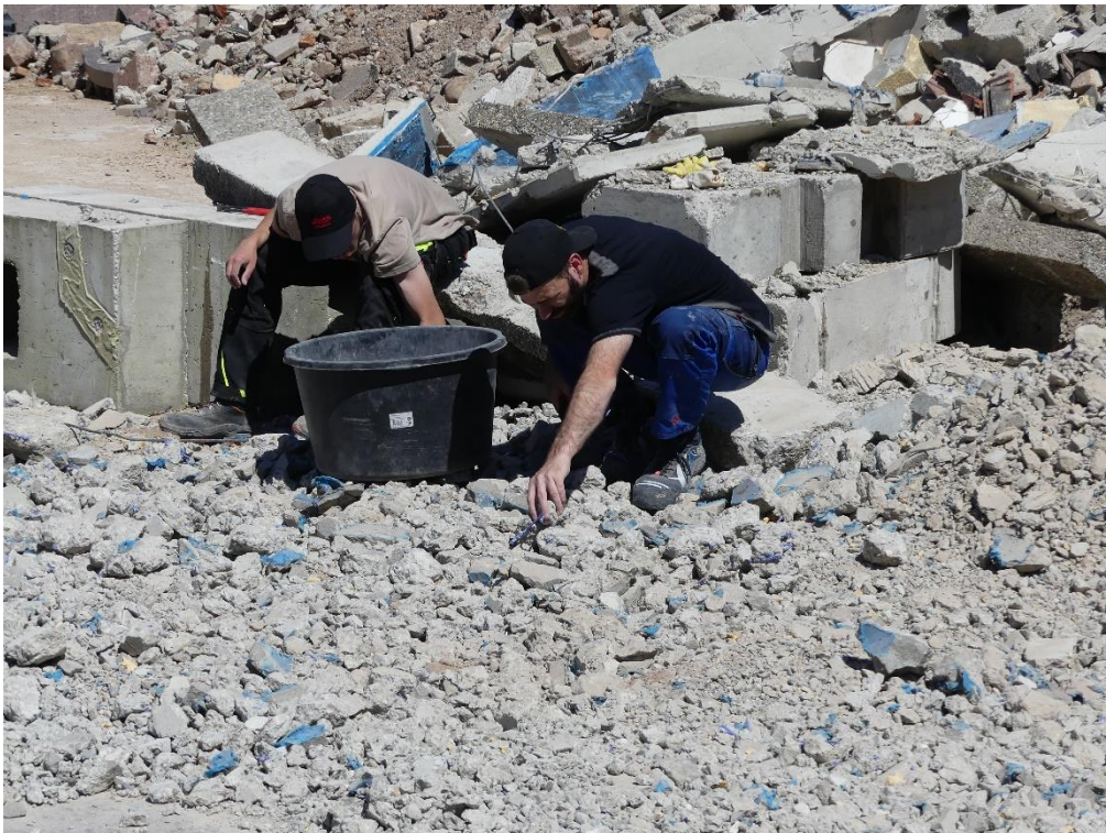
Abbildung 22: Händisches Aussortieren der Rohstoffe
