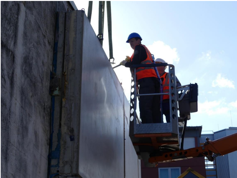
Abbildung 5: Lösearbeiten Stemmeisen
